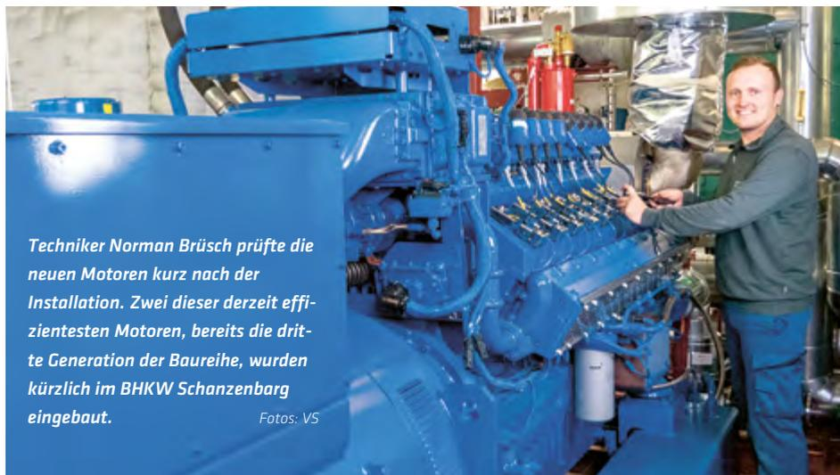
Techniker Norman Brüsich prüfte die neuen Motoren kurz nach der Installation. Zwei dieser derzeit effizientesten Motoren, bereits die dritte Generation der Baureihe, wurden kürzlich im BHKW Schanzenberg eingebaut.
