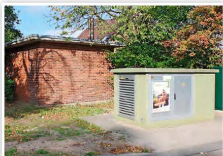
Um die Stromversorgung und -verteilung langfristig auf sichere FüÙe zu stellen, werden gemauerte Trafo-Gebäude sukzessive von kleinen kompakten Stationen ersetzt. An dieser StraÙenecke in Ratzeburg finden sich alt und neu nebeneinander.
