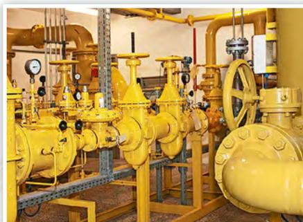
Sogar bei der Lieferung von Erdgas gibt es Einsparpotenzial: Um es in die Haushalte zu leiten, wird in der Gasübergabestation Wärme benötigt. Mit einem eigenen Blockheizkraftwerk lässt sich dabei rund ein Viertel der vorher benötigten Energie einsparen.
