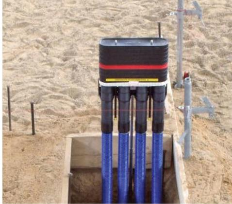
Beim Einbau einer Mehrsparten-Hauseinführung werden mehrere Leitungen durch eine gemeinsame Öffnung in die Gebäudehülle des Hauses geführt.
